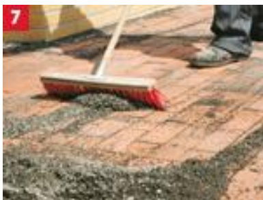
7 Wmiatanie piasku gruboziarnistego w otwarte szczeliny
