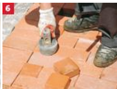
6 Wypełnianie szczelin odpowiednio przyciętymi kostkami
