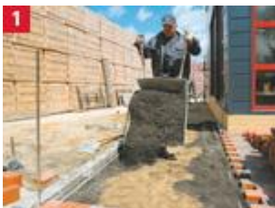
1 Naniesienie drobnego żwiru lub grubo-ziarnistego piasku płukanego na podsypkę (grubość ziaren: 0 - 5 mm)
