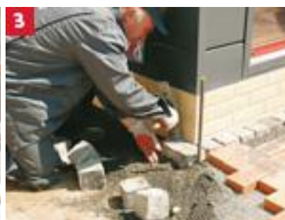
3 Układanie obramowania od strony budynku w postaci kostek granitowych
