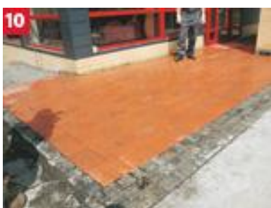
10 Gotowa i wymyta nawierzchnia
