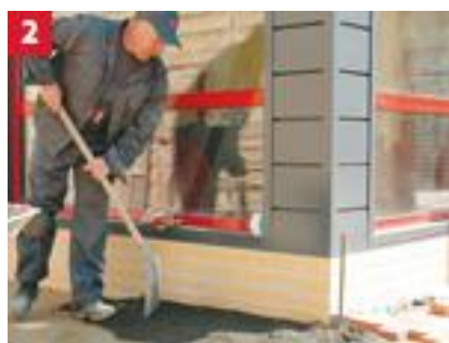
2 Wysypywanie podsypki pod obramowanie bruku od strony budynku
