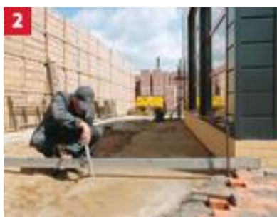
2 Odmierzenie pochylenia za pomocą poziomicy i łąty
