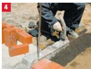
4 Układanie obramowania bocznego w postaci kostek granitowych
