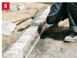
5 Umieszczenie prowadnicy o grubość kostki klinkierowej niżej względem gotowego obramowania bocznego
