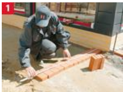
1 Układanie klinkieru w celu ustalenia odstępu między krawędzią a ścianą domu
