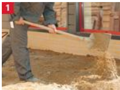
1 Usypanie pierwszej części warstwy nośnej
