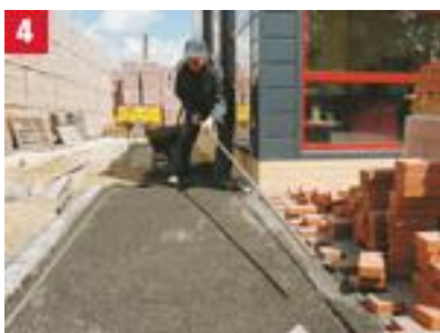
4 Usunięcie prowadnic po wyrównaniu podsypki
