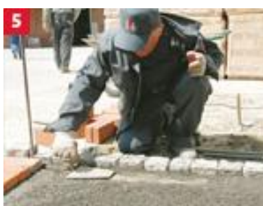
5 Wypełnienie podsypki po usunięciu prowadnic
