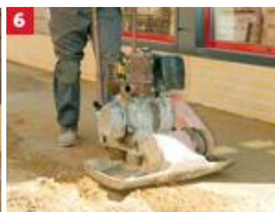
6 Ostateczne ubicie warstwy nośnej z uwzględnieniem spadku 1,5 – 2,0%
