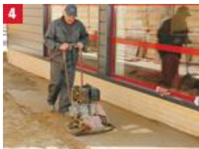
4 Ubijanie poszczególnych warstw mieszanki mineralnej przy pomocy zagęszczarki
