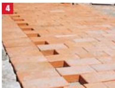
4 Ułożona posadzka klinkierowa z brakującymi połówkami kostek
