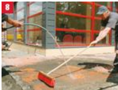
8 Zaszlamowanie szczelin piaskiem za pomocą węża z wodą i szczotki
