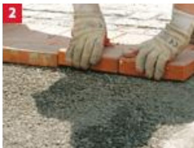
2 Układanie pierwszego rzędu klinkieru
