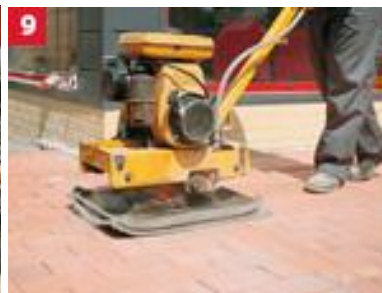
9 Ubicie wybrukowanej powierzchni za pomocą zagęszczarki z gumową płytą, w kierunku od krawędzi do środka.
