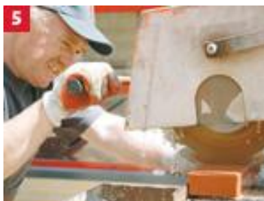
5 Przycinanie pasujących kawałków za pomocą przecinarki lub piły diamentowej
