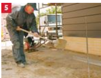
5 Rozmieszczenie dalszych części warstwy nośnej zgodnie z zaznaczonym sznurkiem nachyleniem
