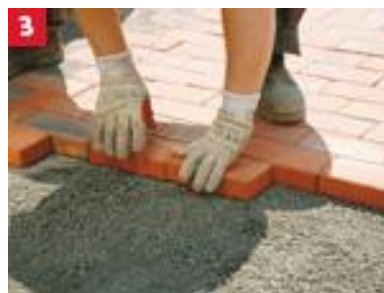
3 Układanie kolejnych rzędów klinkieru
