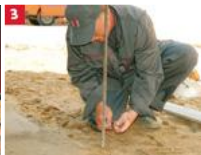
3 Zaznaczenie spadku za pomocą sznurków
