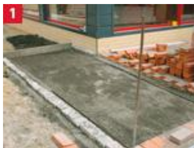
1 Gotowa podsypka wewnątrz obramowania
