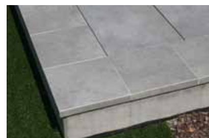
Wykończenie obrzeża w całości z ceramiki stopnicami (patrz zdjęcie) lub kolankami
