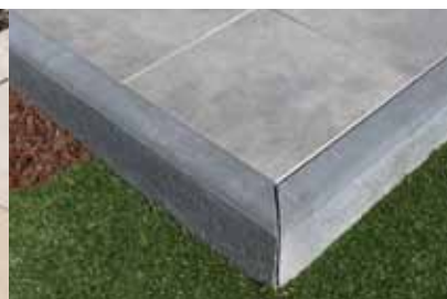
Wykończenie obrzeża krawężnikiem betonowym faszynowym
