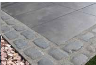
Wykończenie obrzeża kostką brukową
