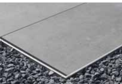
Wykończenie obrzeża profilem ze stali szlachetnej
