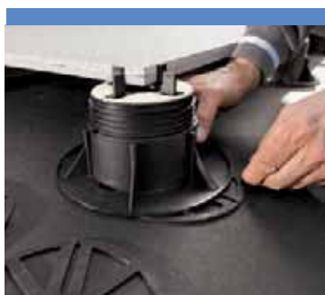
Disco LH3 (3 mm) o altro spessore LH3 levelling disc (3 mm) or other shim Disco nivelador LH3 (3 mm) u otro espesor
