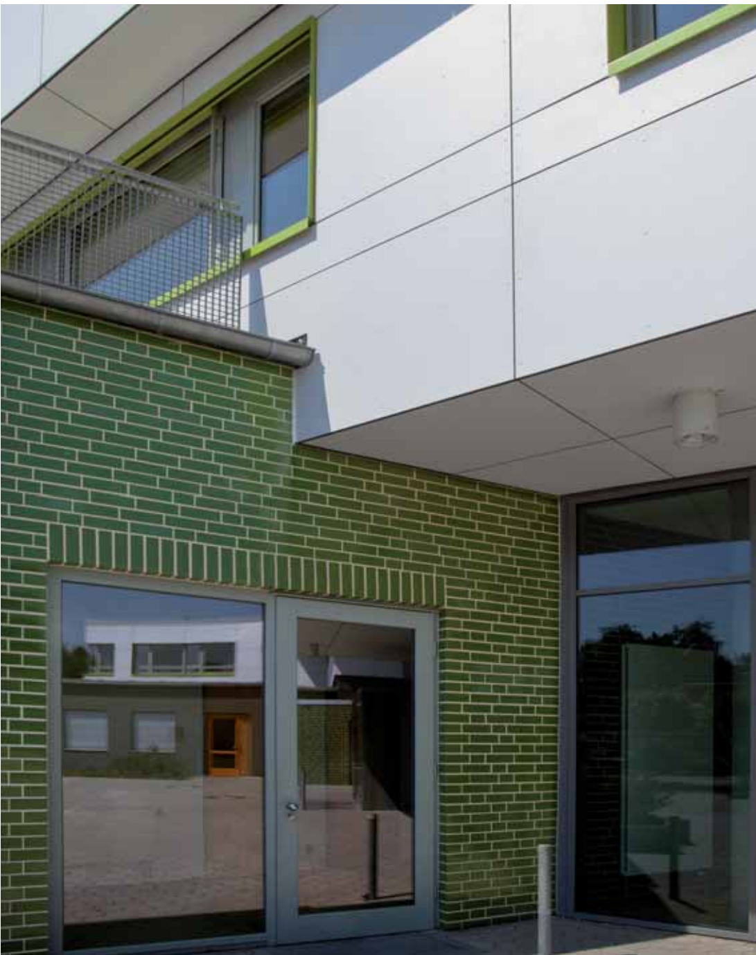
Wilhelm-Busch-Schule. Neubau des Schulzentrums Wiesenfeld in Glinde/Hamburg Architektur: Trapez Architektur, Hamburg · www.trapez-architektur.de
