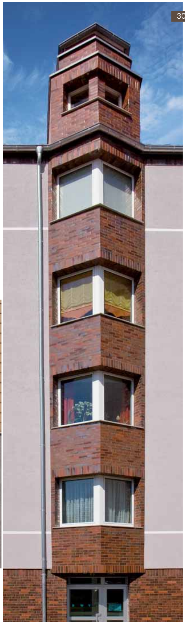
Erker mit ABC-Keramikfassade im Klinkerformat
