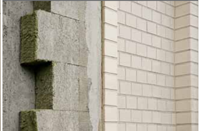
Quartiersteinverlegung auf WDV-System
