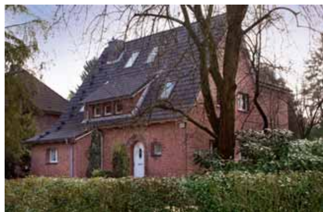
Sanierung eines Wohnhauses der 30-iger Jahre, Hamburg
