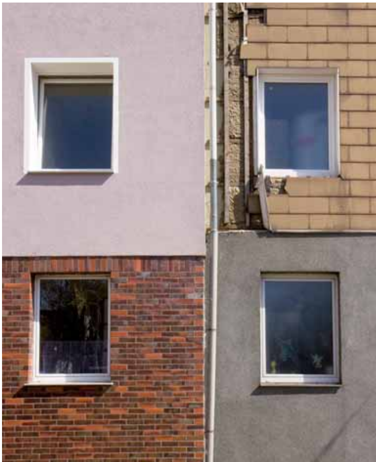
Fassade nach und vor der Sanierung
