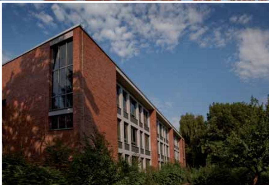
Sanierung und Energiesparmaßnahmen der Schulgebäude »Denksteinweg« in Hamburg
