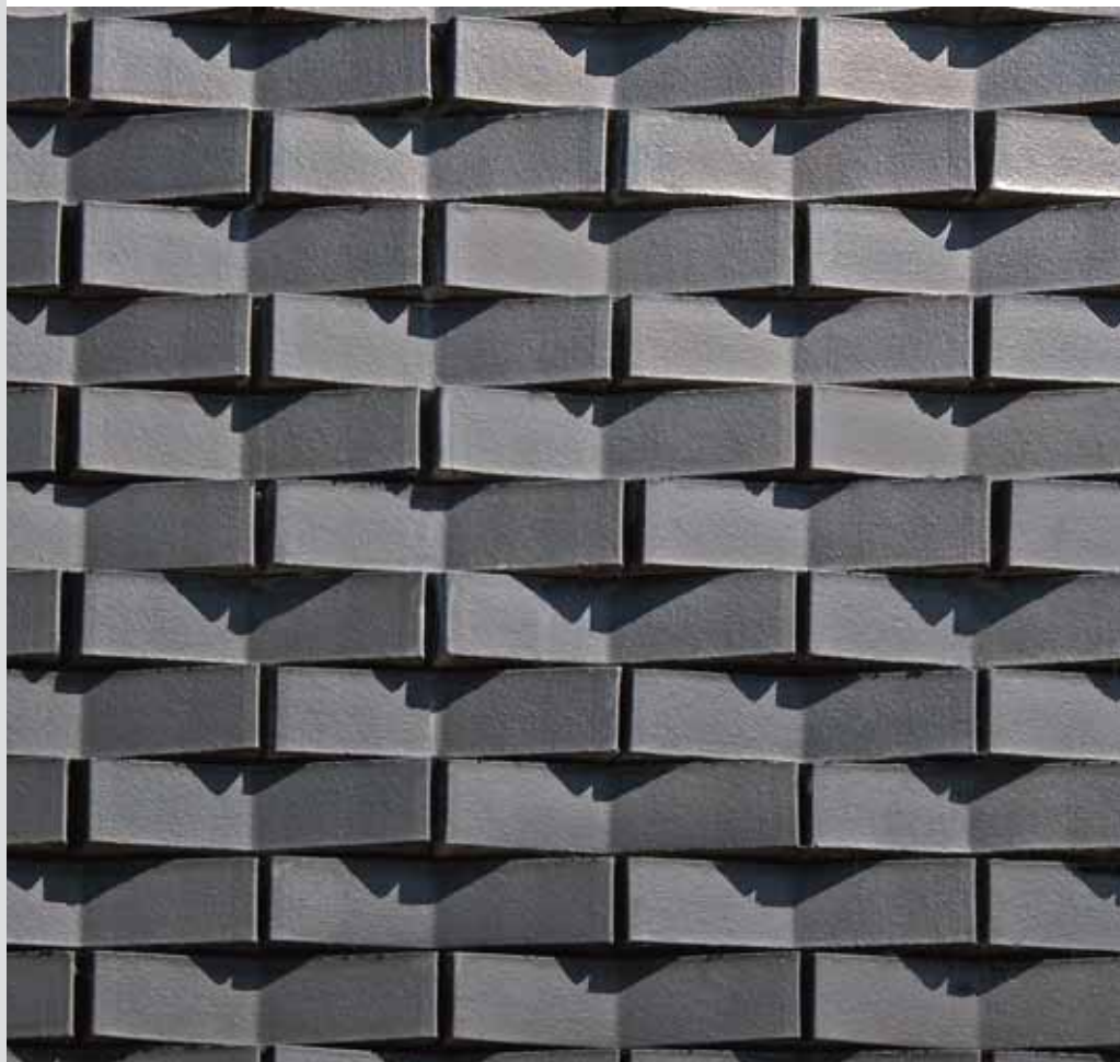
Ansicht von vorne: Schattenklinker ohne Mörtelfuge geklebt
