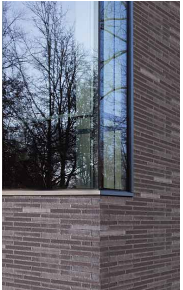
36101 aquaterra Rauchscharz 365 x 115 x 52 mm Fugmörtel + dunkler Splitt, Körnung 1,8–3 mm
